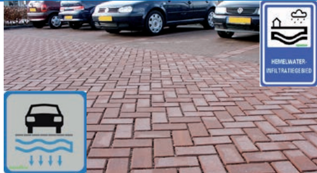
Figuur 40 Waterpasserende verharding en aanduiding gebied met waterpasserende verharding (bron: Aquaflow)
