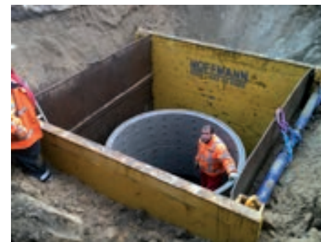
Figuur 46 Plaatsing van een infiltratieput (bron: Anne Melse)
