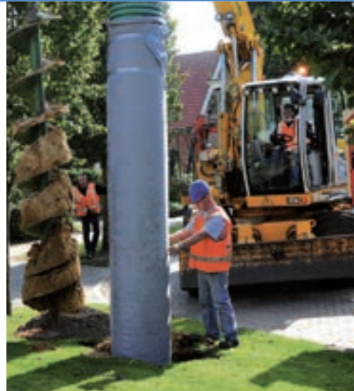
Figuur 42 Plaatsing verticale infiltratiebuis (bron: Wavin)
