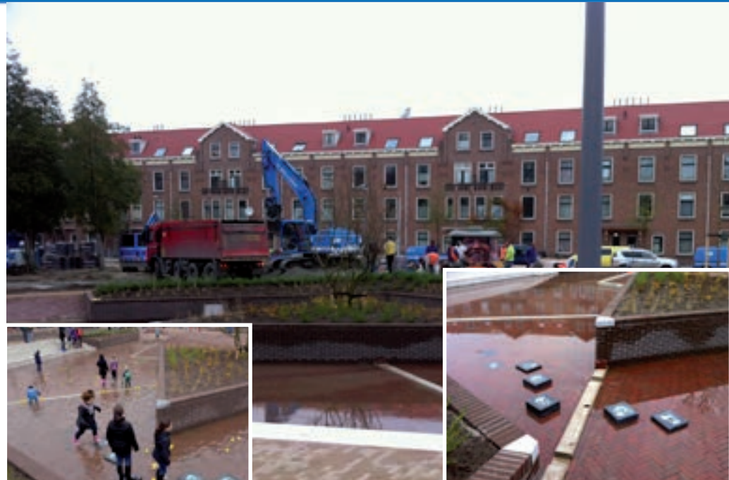
Figuur 34 Voorbeeld waterplein combi speelplek- Bellamyplein Rotterdam (bronnen: Anne Melse, www.rotterdam.nl )
