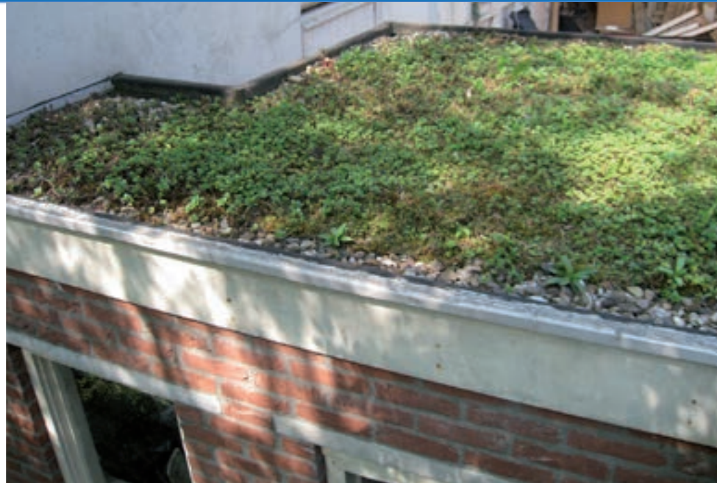
Figuur 33 Sedumdak (bron: Stichting duurzame wijk - St. Marten-Sonsbeekkwartier)
