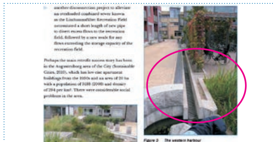
Figuur 68 Voorbeeld zichtbare afvoergoot - kanaaltje (Bron: Ciria, 2012)
